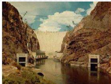
Hoover Dam premier barrage en béton, 1936
