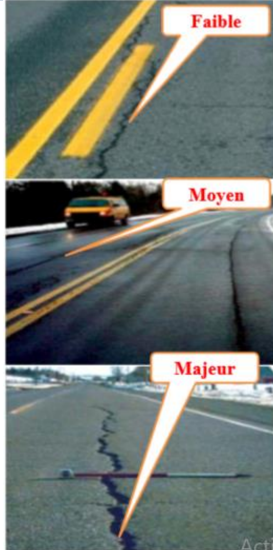
Fissures longitudinales
