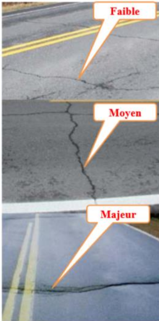
27 Fissures transversales
